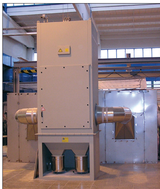
VARIO 3 pour ventilation d'une cabine de meulage
