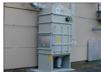
Event d'explosion pour décharge d'explosion en extérieur
