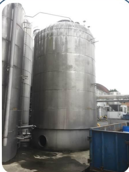
( x1) HOLVRIEKA - 52,5m 3 - 525 HL inox 316L - calorifugée
