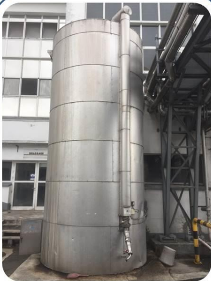
(x1) AMYLUM - 23m 3 - 230 HL Inox 316 – Calorifugée
